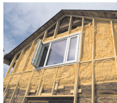
Energię oszczędzimy również dzięki ociepleniu budynku. Fot. Depositphotos/ Pilens
